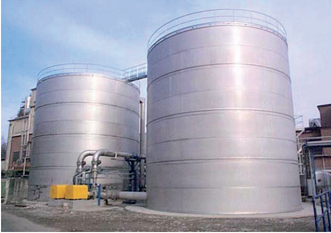
Serbatoi di stoccaggio / Storage Tanks
